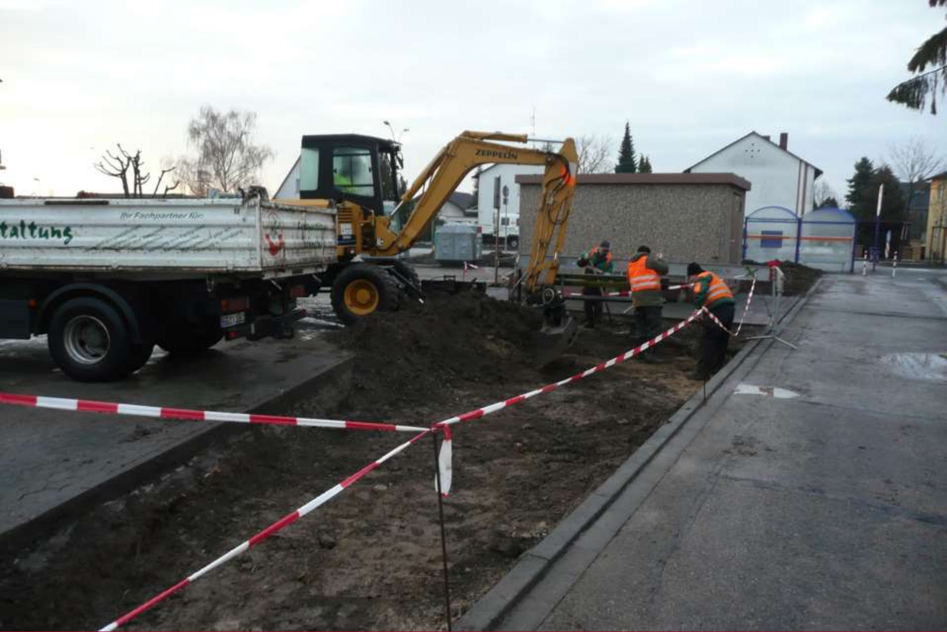
Beispiel Kurt-Schumacher-Straße : Entnahme des alten Oberbodens (04.02.1010)
