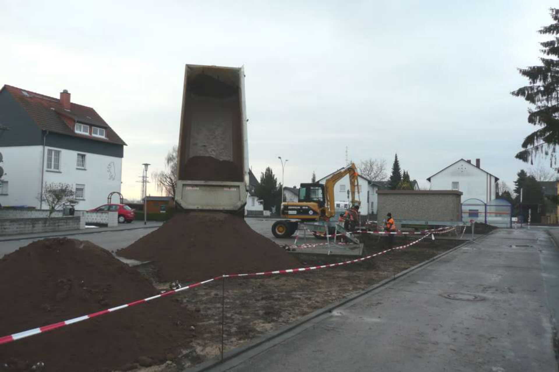
Einbau des neuen Vegetationssubstrats (08.02.2010)
