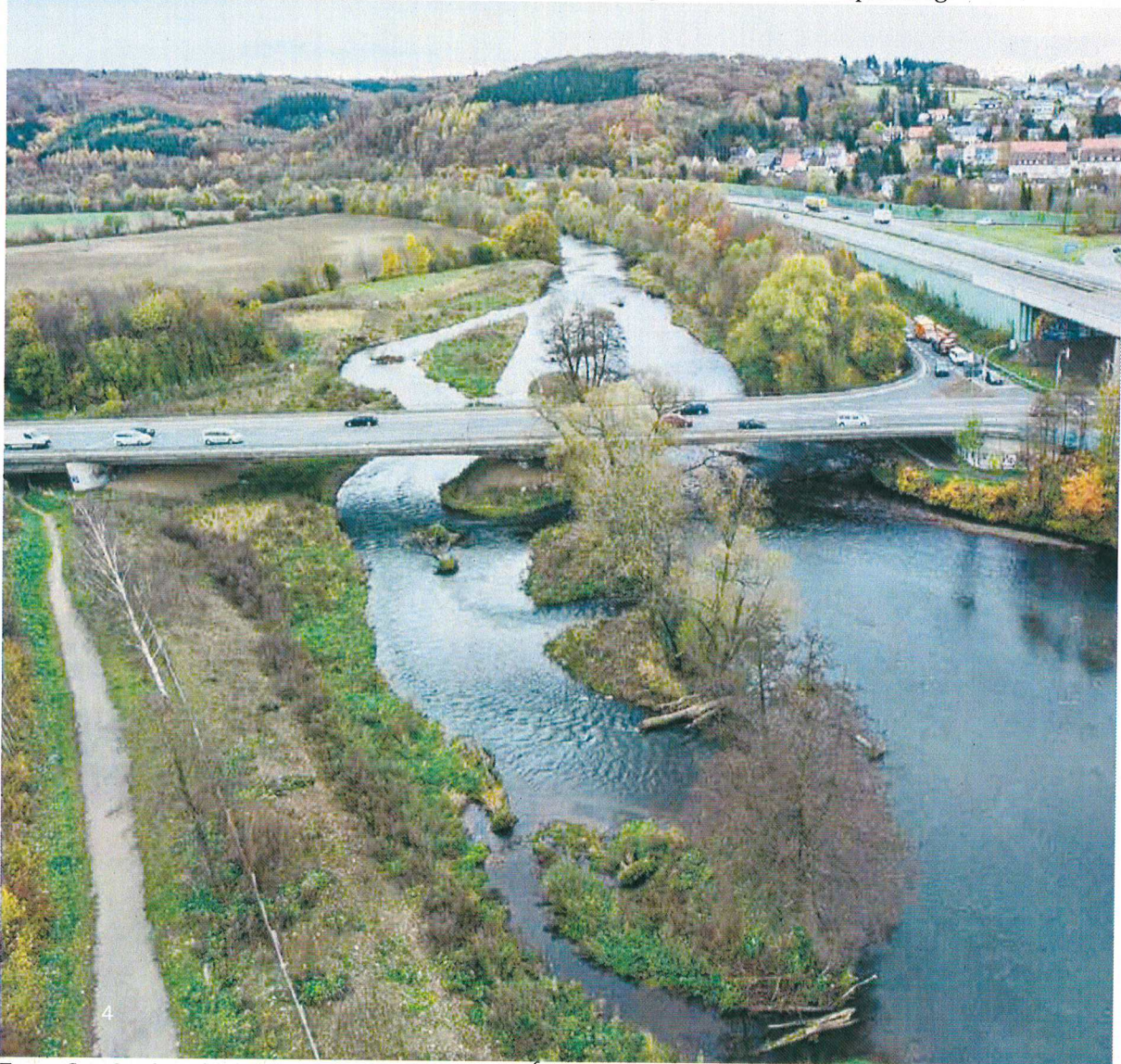
Foto: Straßenbrücke über die Ruhr in Arnsberg 6
