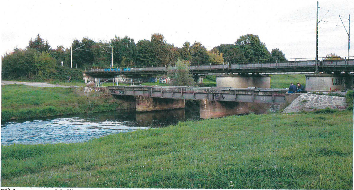
EÜ Luppe: Müllbergbrücke (Abbruch geplant)
