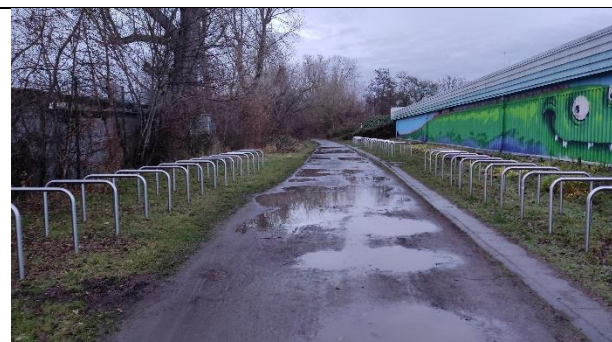
Weg 1205: südlicher Anschluss am Freibad Schönefeld
