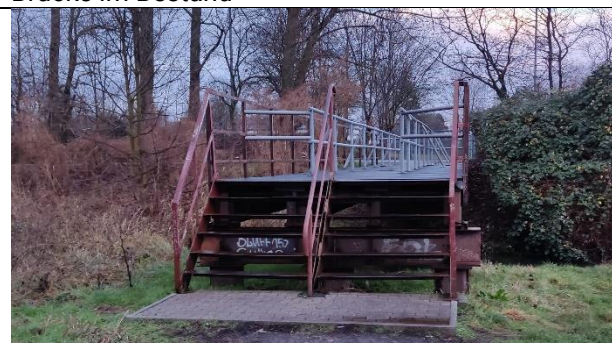
Widerlager West: Gründung wird mit Mikropfählen verbreitert
