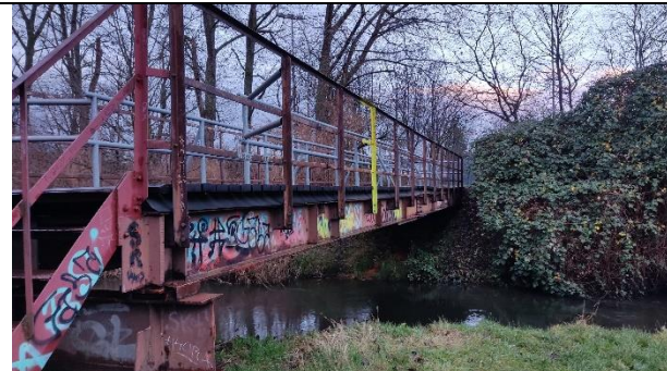
Brücke im Bestand
