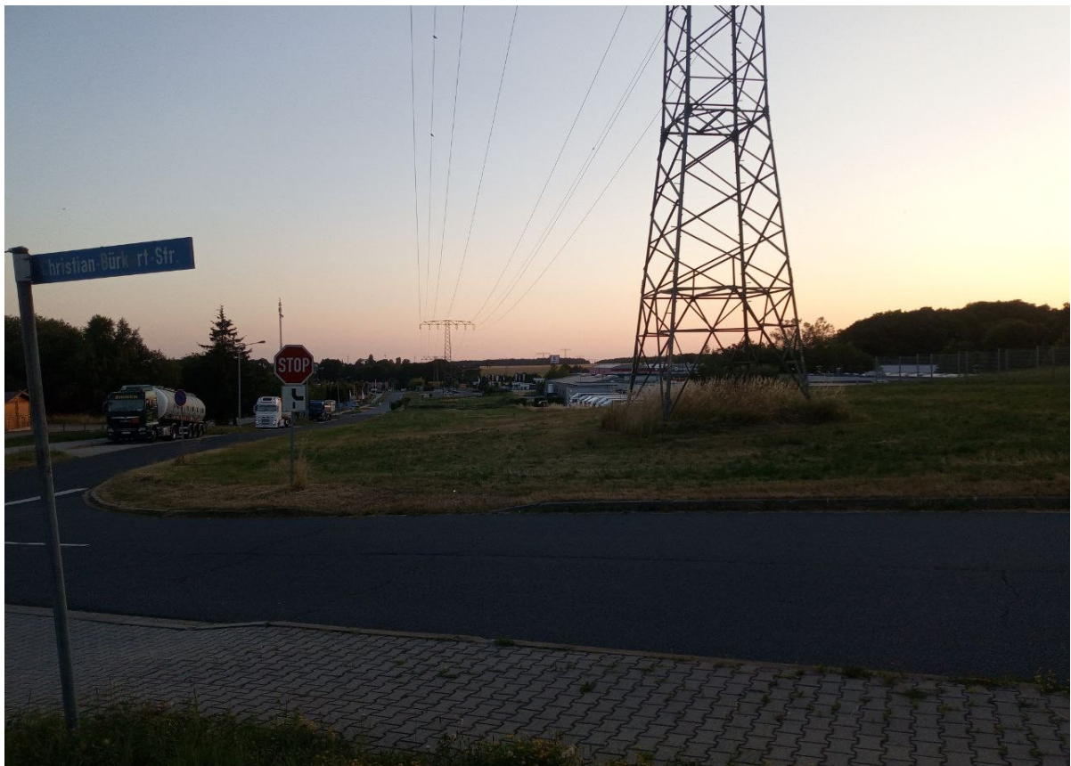
Fotobelege für freie Flächen innerhalb des Bestehenden Gewerbegebietes
